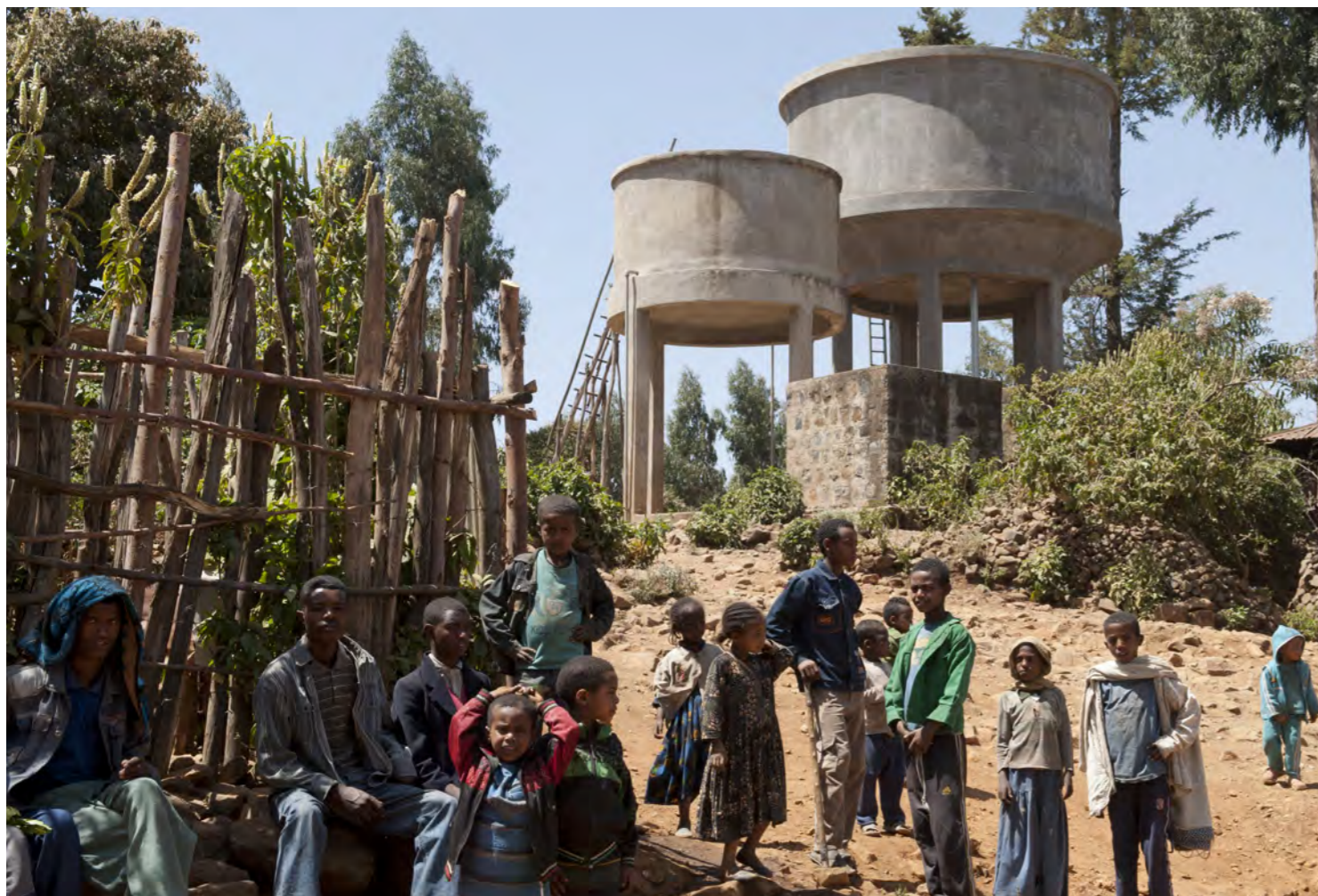
Das Hochreservoir über der Stadt Lemmi fasst 100 Kubikmeter.
