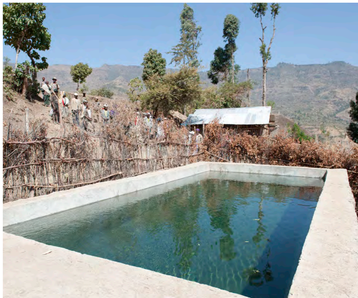
Im 2.200 Meter hoch gelegenen Dorf Tabeat betonierte Menschen für Menschen ein Reservoir für die Bewässerung der Felder.
